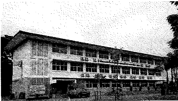
(ก) อาคารสำนักงานเขตพื้นที่การศึกษา นครราชสีมา เขต 6 อ.บัวใหญ่ จ.นครราชสีมา ซึ่งนำแบบ สปข.2/28 มาประยุกต์ใช้ ภาพที่ 1 แสดงการเปรียบเทียบทางกายภาพ แบบอาคารเรียน 3 ตามแบบ สปข. 2/28
